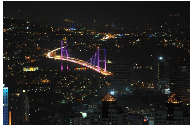
Bosphorus Bridge (Turkey)
